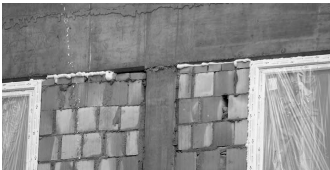
Rys. 16. Nieodpowiednie wypełnienie szczeliny pod rygłem pianką poliuretanową. Widoczne liczne niedokładności wykonania ścian (fot. S. Gąsiorowski).
