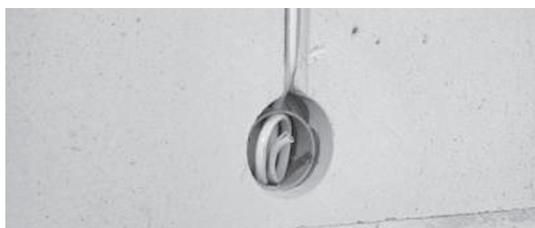
Rys. 16. Instalacja elektryczna przygotowana do zakrycia tynkiem.
