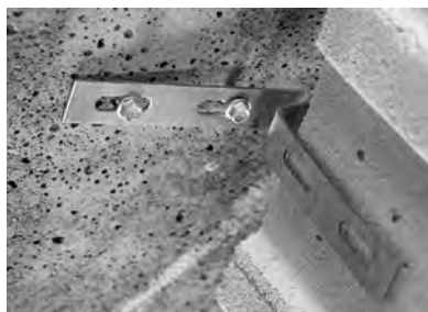
Rys. 9. Połączenie górnej krawędzi ściany ze stropem za pomocą łączników w spoinie czołowej wypełnionej zaprawą.
