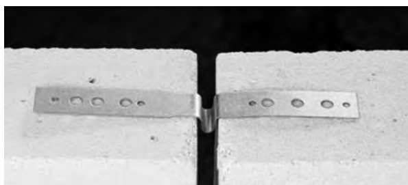
Rys. 13. Metalowy łącznik (symbol D3 ) do połączenia odcinków ściany w szczelinie dylatacyjnej.
