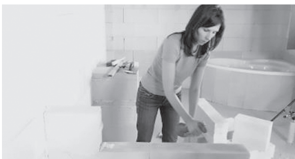
Rys. 27. Zwilżanie powierzchni suchych bloczków przed nałożeniem kleju poliuretanowego.
