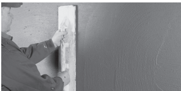
Rys. 21. Tynk cementowo-wapienny SOLBET 5.1 w trakcie zaciągania.
