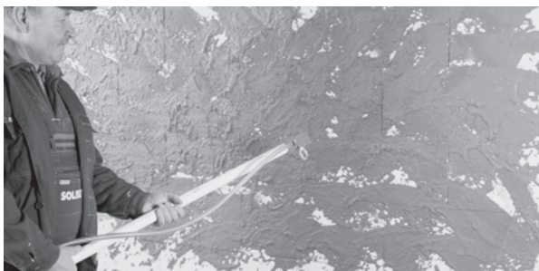
Rys. 18. Tynk maszynowy SOLBET cementowo-wapienny 5.2 nakładany na ścianę z betonu komórkowego.
