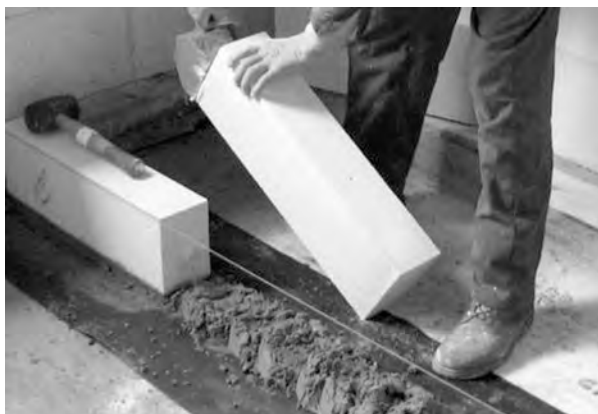
Rys. 3. Murowanie pierwszej warstwy na zaprawie Tradycyjnej SOLBET o.5.
