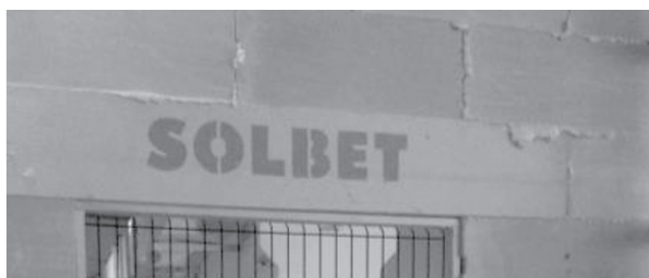
Rys. 32. Prawidłowe oparcie nadproża ze zbrojonego betonu komórkowego w ścianie działowej wykonanej w systemie SOLBET SMART (na kleju poliuretanowym).
