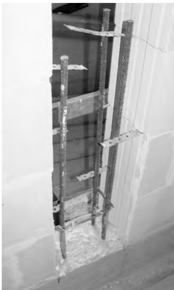
Rys. 15. Widok nawiązki zbrojenia rdzenia wypuszczonej ze stropu oraz łączników wypuszczonych ze ściany wypełniającej.
