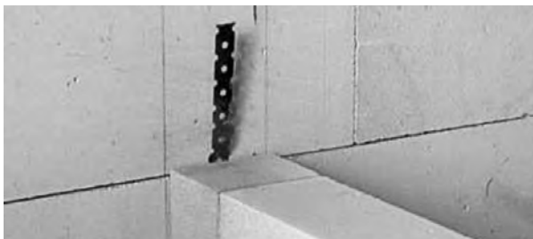
Rys. 7. Połączenie ściany działowej ze ścianą konstrukcyjną za pomocą łączników P30 (stalowych ocynkowanych).
