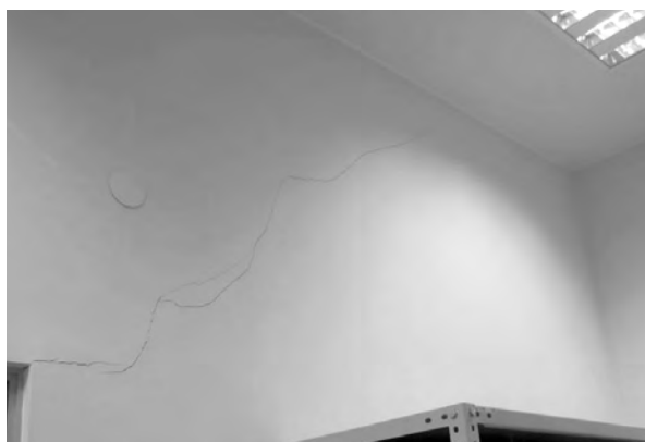
Rys. 18. Zarysowanie ścian wypełniających w budynku pokazanym na rys. 15 i 16.
