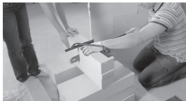
Rys. 24. Docinanie bloczków za pomocą piły ręcznej i prowadnicy kątovej.
