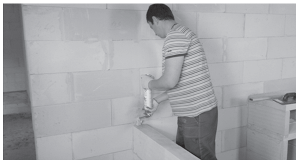
Rys. 29. Nakładanie kleju poliuretanowego SOLBET SMART na powierzchnię bloczków z betonu komórkowego SOLBET za pomocą pistoletu.
