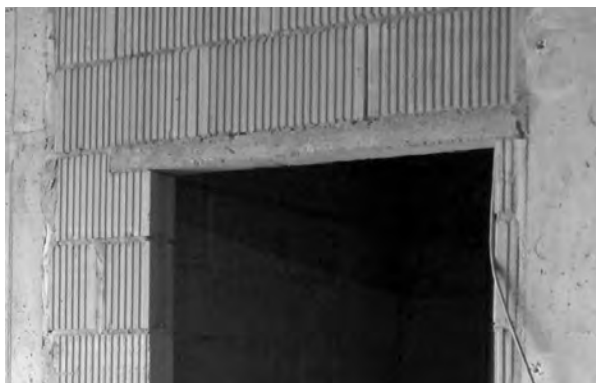
Rys. 17. Oparcie nadproża ścianki wypełniającej na zbyt wąskim filarku (fot. L. Misiewicz).
