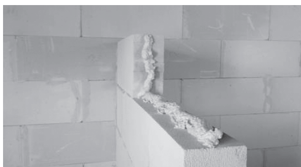
Rys. 31. Kolejne fazy przyklejania bloczka z betonu komórkowego SOLBET klejem poliuretanowym SOLBET SMART.
