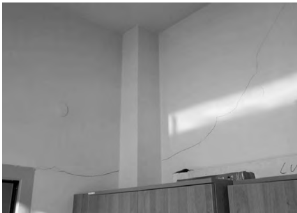
Rys. 17. Zarysowanie ścian wypełniających w budynku pokazanym na rys. 15 i 16.
