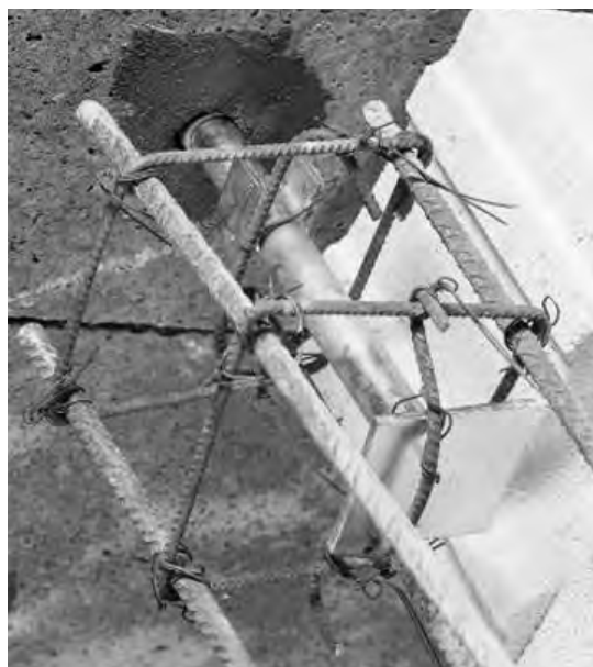
Rys. 13. Widok tulei osadzonej w stropie, stanowiącej górną podporę rdzenia.
