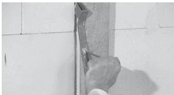
Rys. 14. Sposób wykonania bruzdy w murze z betonu komórkowego.
