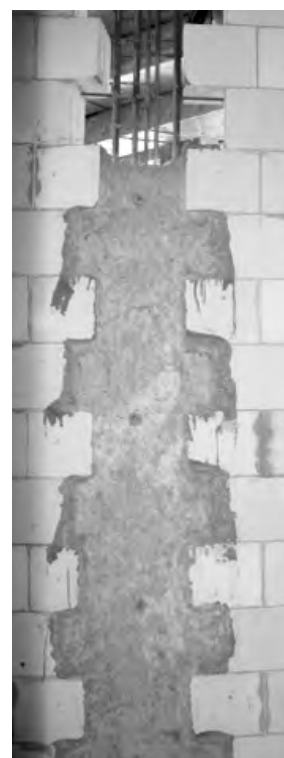
Rys. 14. Częściowo wykonane rdzenie w ścianie prostej i zakrzywionej [5].
