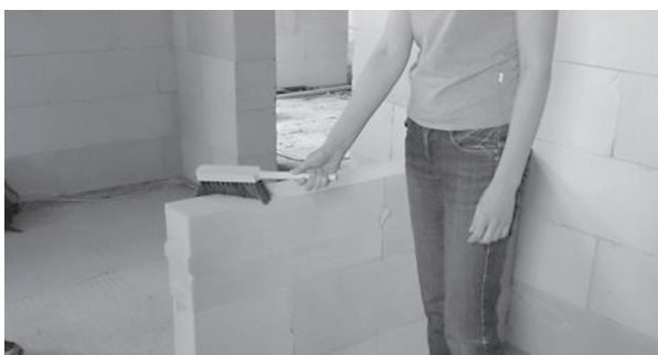
Rys. 26. Usuwanie pyłu z powierzchni bloczków przed nałożeniem kleju poliuretanowego.
