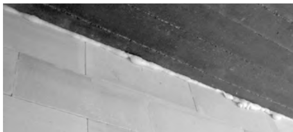
Rys. 11. Trwale elastyczna piana o dużym stopniu odkształcalności (np. Flexifoam) wypełniająca szczelinę pomiędzy ścianą działową a stropem.
