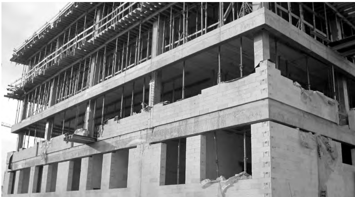
Rys. 15. Murowanie ścian wypełniających i osłonowych na podpartych stropach.
