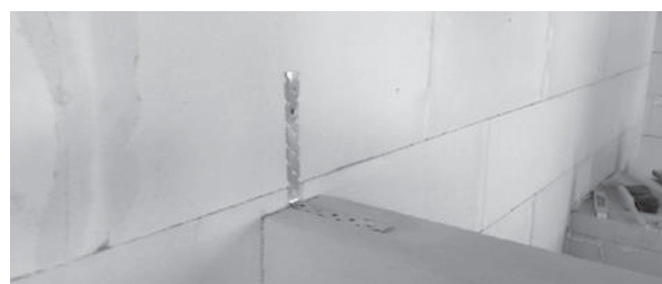
Rys. 33. Kolejne fazy mocowania łącznika w spoinie muru wykonanego w systemie SOLBET SMART na kleju poliuretanowym.
