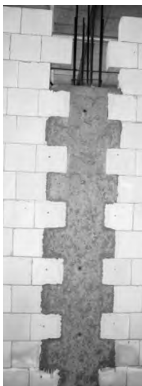
Rys. 14. Częściowo wykonane rdzenie w ścianie prostej i zakrzywionej [5].
