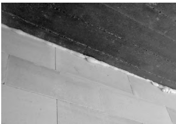
Rys. 27. Trwale elastyczna piana do wypełnienia szczeliny pomiędzy ścianą działową a stropem.
