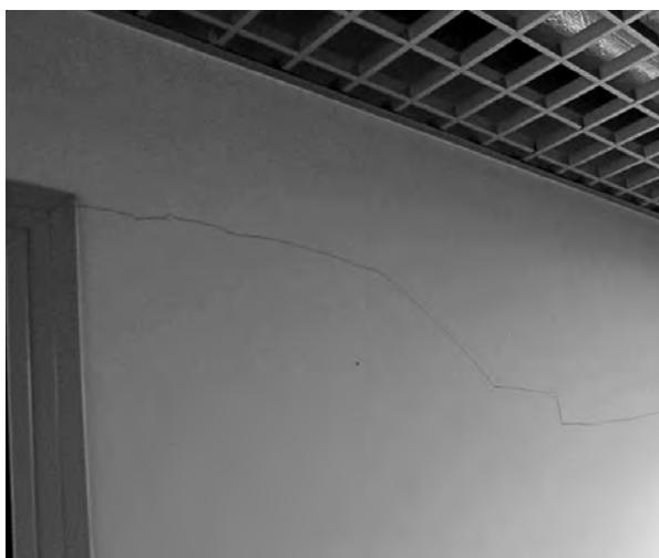
Rys. 6. Zarysowanie w rejonie naroży otworu drzwiowego.
