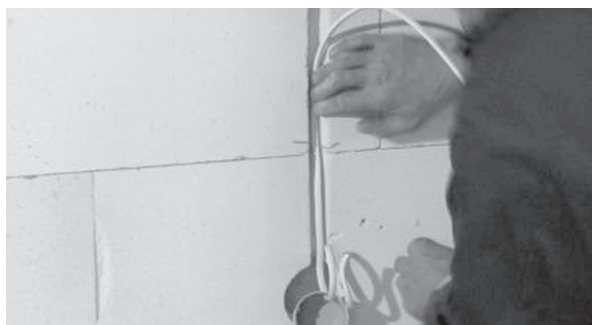
Rys. 15. Układanie instalacji w bruzdzie instalacyjnej.
