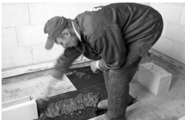
Rys. 5. Folia jako przekładka oddzielająca ścianę działową od podłoża.
