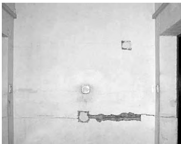
Rys. 9. Przykłady zarysowań ścian wypełniających.
