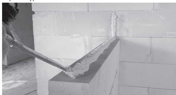
Rys. 30. Klej poliuretanowy SOLBET SMART powinien być nakładany pasem o szerokości ok. 30 mm.
