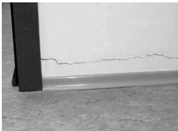
Rys. 3. Pozioma rysa w dolnej części ściany.
