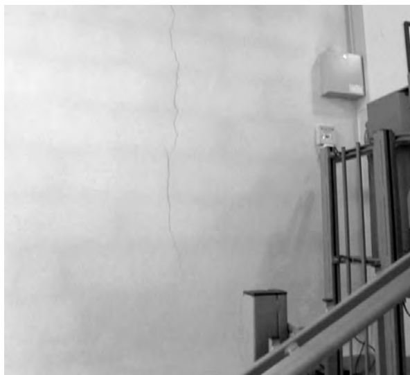
Rys. 21. Przykład ściany z klasyczną rysą skurczową.
