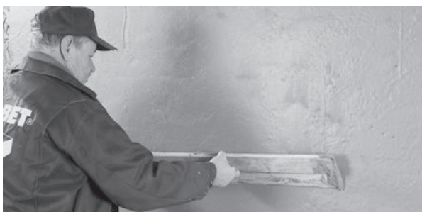
Rys. 19. Tynk maszynowy SOLBET w trakcie zacierania.
