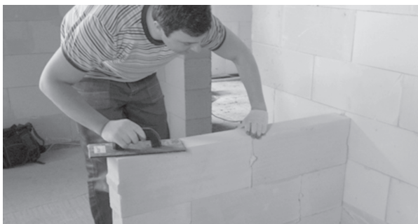
Rys. 25. Szlifowanie górnej powierzchni bloczków przed murowaniem kolejnej warstwy.
