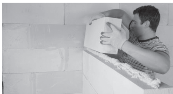
Rys. 30. Klej poliuretanowy SOLBET SMART powinien być nakładany pasem o szerokości ok. 30 mm.
