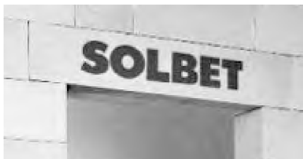
Rys. 4. Nadproża SOLBET w ścianie działowej.
