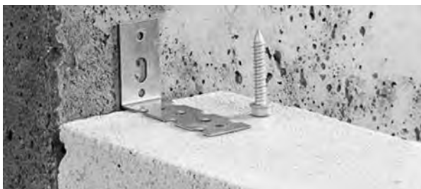
Rys. 8. Połączenie ściany działowej z żelbetowym elementem konstrukcyjnym za pomocą łącznika K1 (stalowy ocynkowany).
