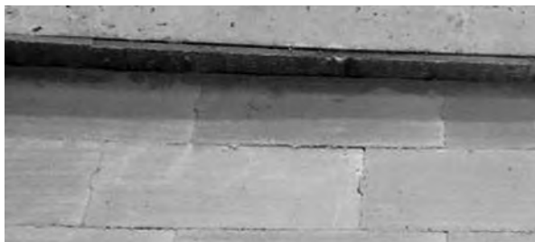
Rys. 10. Wełna mineralna (jeszcze przed docięciem) wypełniająca szczelinę podstropową (w tym przypadku pod krawędzią stropu).
