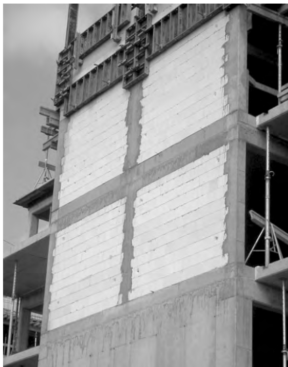
Rys. 11. Przykłady murów skrzepowanych.
