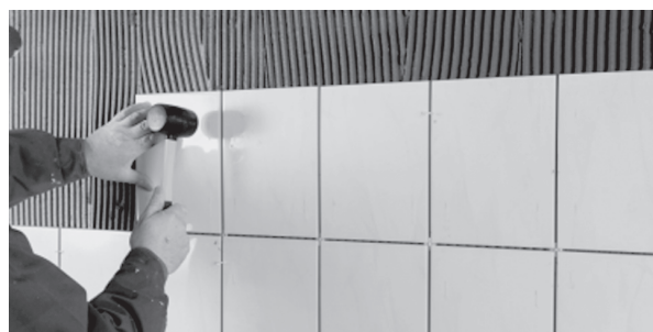
Rys. 23. Przyklejanie płytek za pomocą zaprawy klejącej SOLBET Gabit INTERIOR 7.3.
