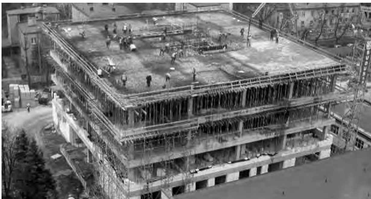
Rys. 16. Murowanie ścian wypełniających i osłonowych na podpartych stropach.
